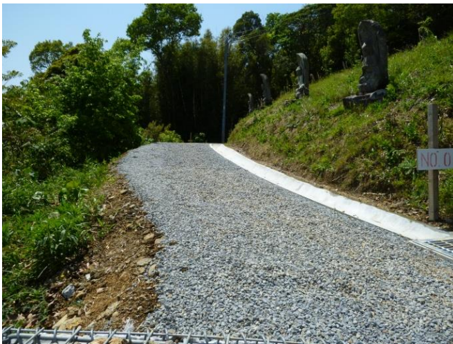
②正面階段：石像 1 番からの遊歩道と排水路
