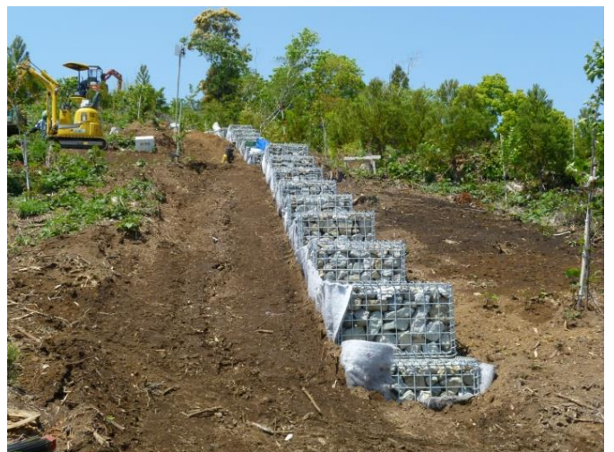
⑤北側斜面地にゆっくり水を流すための排水路
